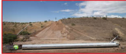
Alcantarilla de 4.88 mts. de diámetro con 35 mts. de colchón.
